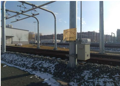
哈地铁车辆段综合实训基地
