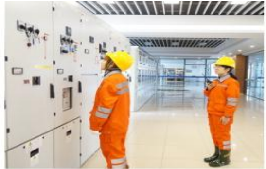
图 3-48 三工位开关倒闸操作过程
