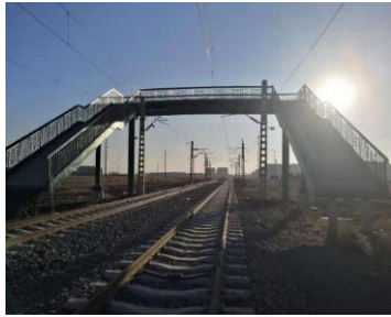
图 3-27 线路维护实训区
