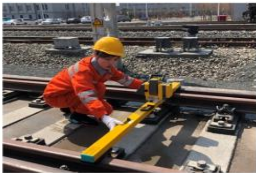
图 3-47 轨距测量仪器操作
