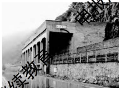
图 1.19 刚架式棚洞
