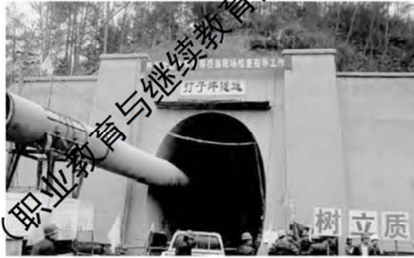
图 1.9 柱式洞门
